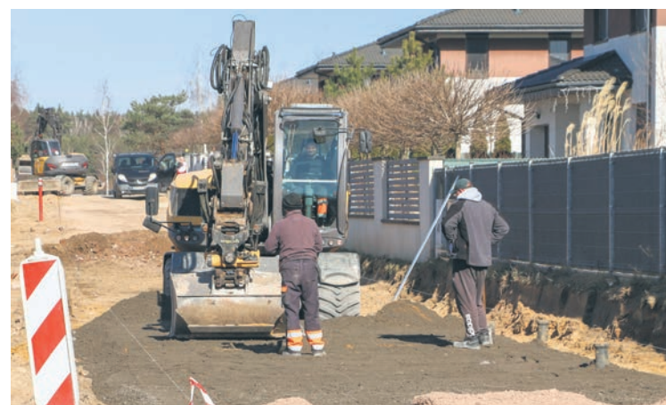
Budowa asfaltowej nakładki na ul. Kowalika w Skierdach
