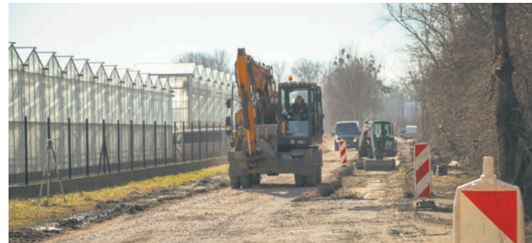
Prace na ul. Golfowej w Rajszewie
