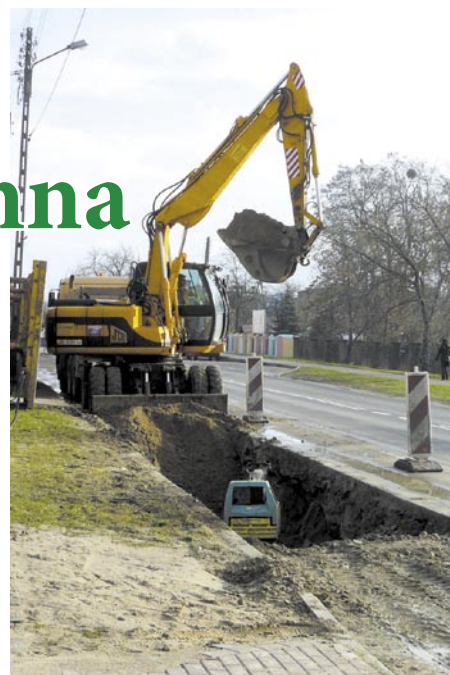
Budowa kanalizacji na ul. Modlińskiej
